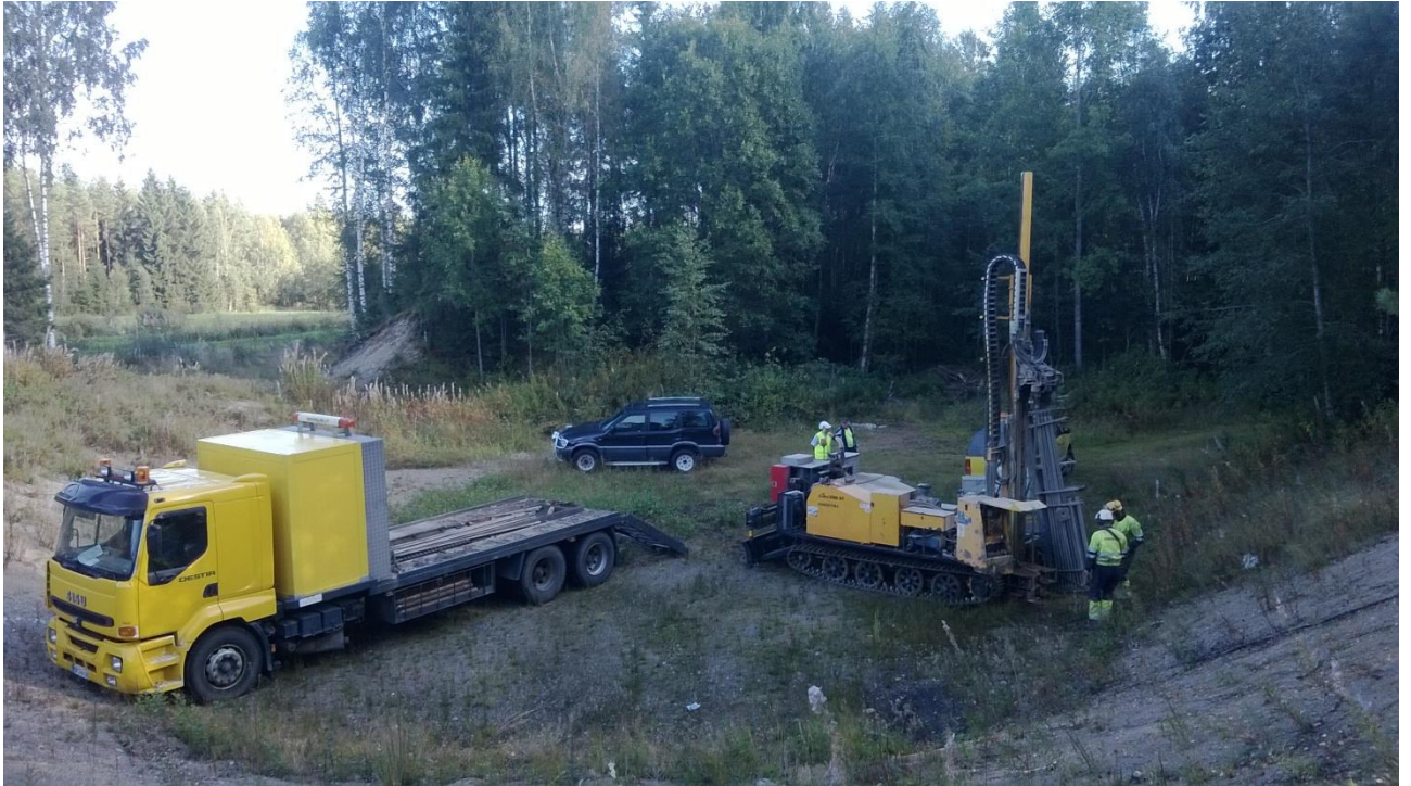
Kuva 2. Tutkimuksissa käytetty kairauskalusto, Mäntylänharju Parkano. Kuva: Nina Nenonen 27.8.2013
