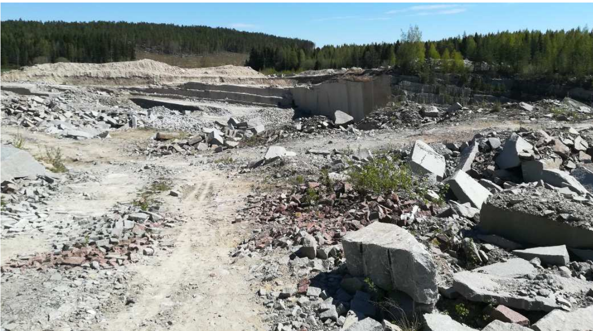
Kuva 12. Sivukiveä hyödynnetään usein louhimon omassa maa- ja tierakentamisessa. Kuva: Iris Havola
