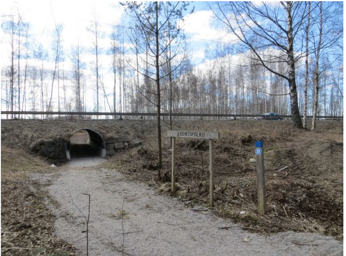
Kuva 5-12. Valtatien 12 alikäytävä, joka yhdistää Kuohunlahden ja Kirkkojärven itärannan. (Kuva: Satu Appelqvist.)
